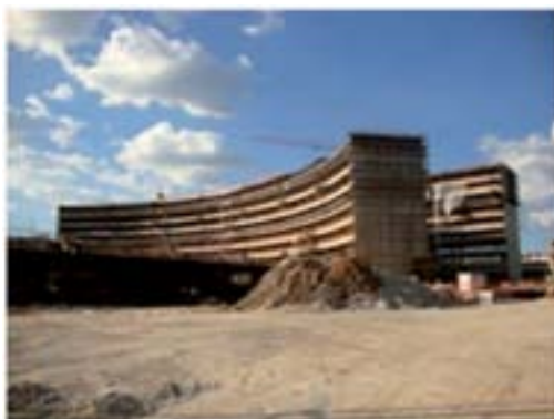
Dezembro 2012 – colocação de formas para concretagem da laje de piso do 8º pavimento do bloco A e do 9º pavimento do bloco D.
