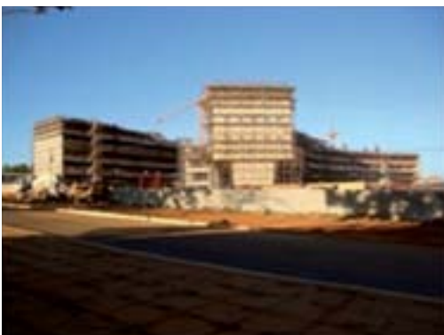
Julho 2012 – execução da laje de piso do 4º pavimento do bloco A e do 5º pavimento do bloco D.
