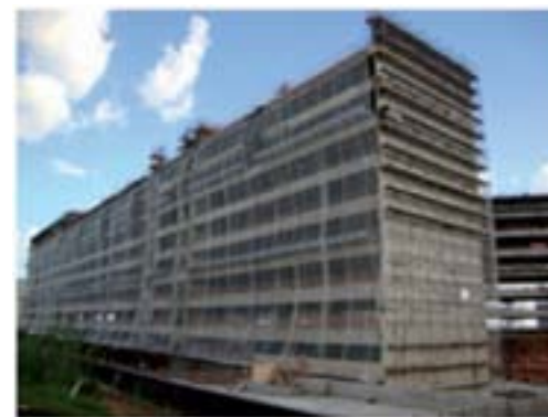
Dezembro 2012 – colocação de formas para concretagem da laje de piso do 8º pavimento do bloco A e do 9º pavimento do bloco D.
