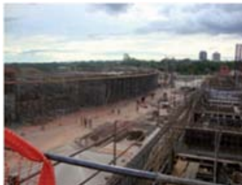
Janeiro/fevereiro 2012 – execução dos pilares dos pilotis e, em seguida, das primeiras lajes de piso de pavimento dos blocos A e D.
