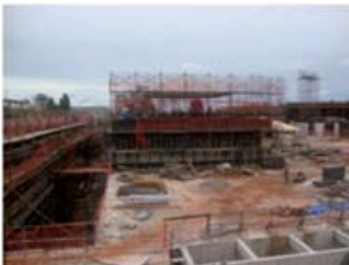
Janeiro/fevereiro 2012 – execução dos pilares dos pilotis e, em seguida, das primeiras lajes de piso de pavimento dos blocos A e D.
